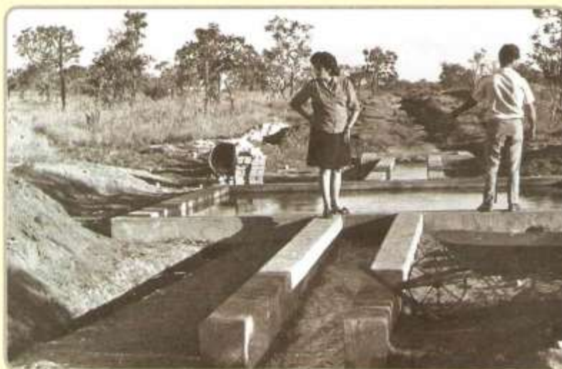
Tia Neiva, vistoriando as obras de captação de água para o Vale.
