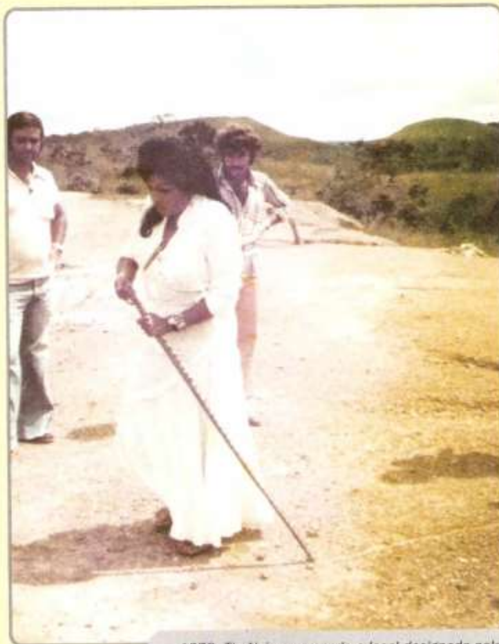
1978. Tia Nelva marcando o local designado pelas entidades para dar início às obras do Lago.
